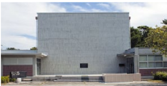
● JRR-1 (研究炉 No.1) 建家
