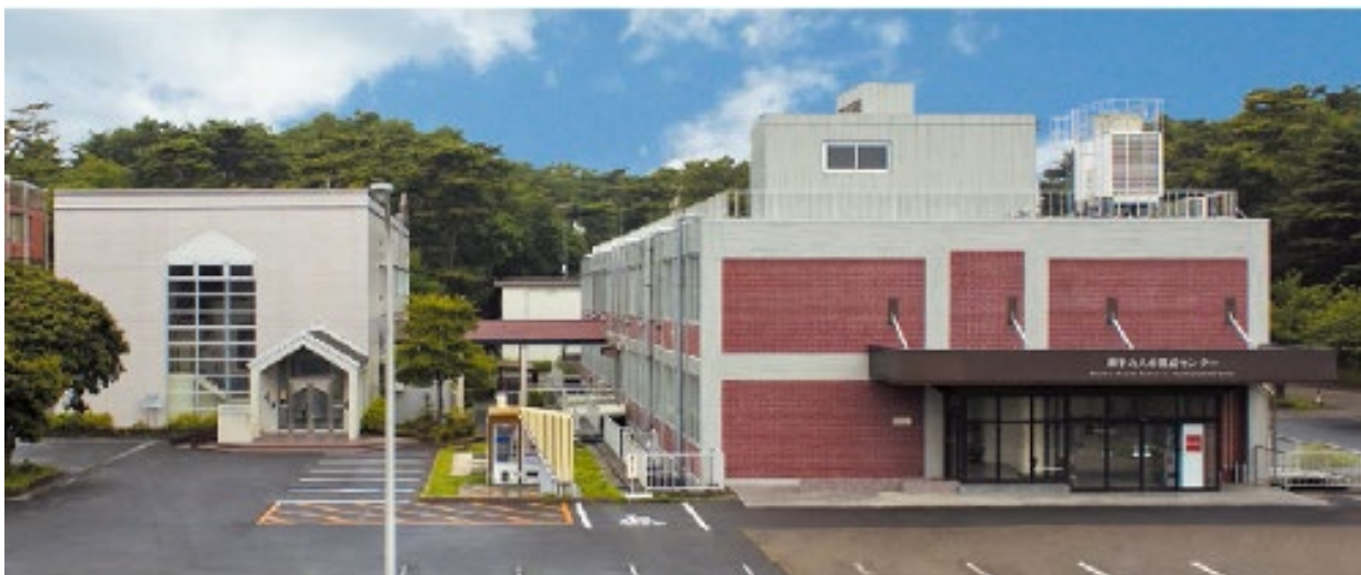
●左：研修講義棟（地上2階）、右：原子炉特研建家（地上2階、地下1階）
